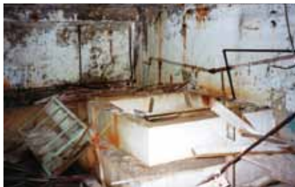
조선인이 수용된 4층 건물의 지하
