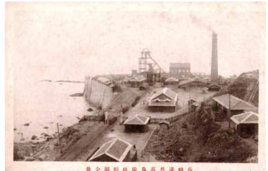
다카시마 가키세갱 전경(엽서)
