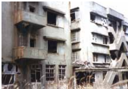
조선인이 수용된 4층 건물
