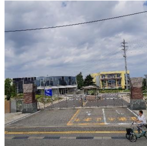
富山市内の不二越の正面玄関／愛本ダム
