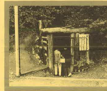
象山地下壕の入口（西条・恵明寺口）
