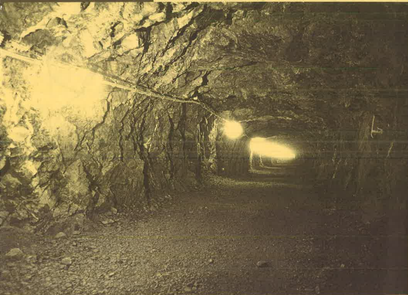
■ 松代象山地下壕の現況 ■
