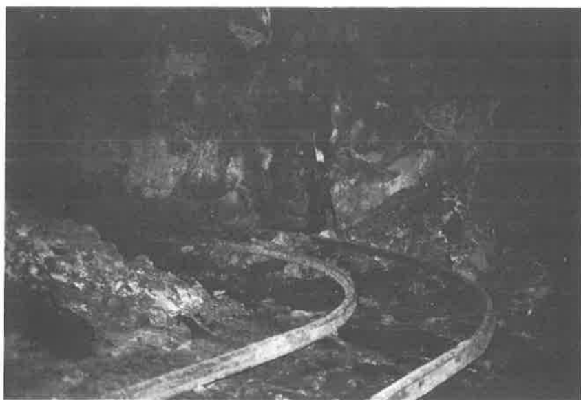
甲陽園西山町の地下トンネルに残るレール
